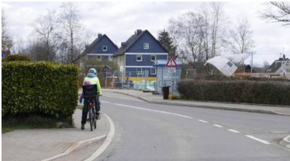
Abbildung 1: Lebensgefährliche Führung eines kombinierten Rad- und Fußweges für beide Richtungen (!) in Rodt
