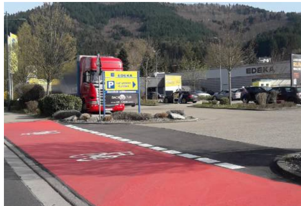
Abbildung 3: Beispielhafte Radwegmarkierung im Bereich einer Ausfahrt (Haslach, BW)
